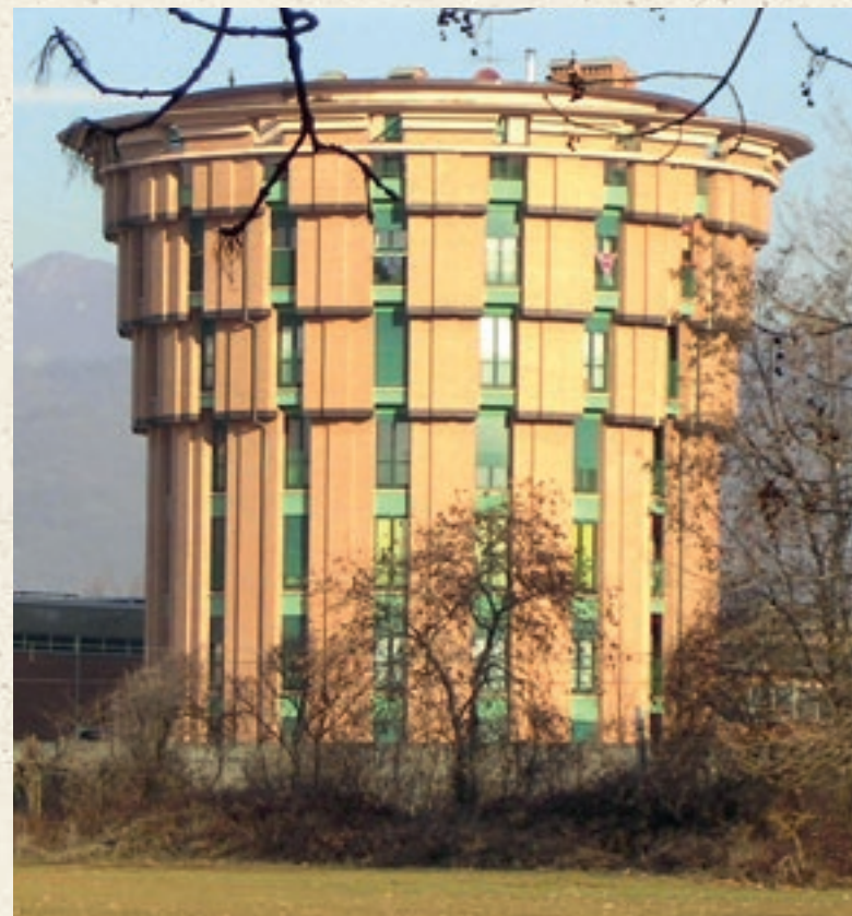
Seriate, "Torre" circolare per la Cooperativa di Abitazione Sebina (Gambirasio con Tomasi).
