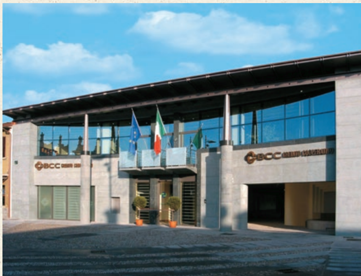
Veduta esterna della sede di Calcio.
