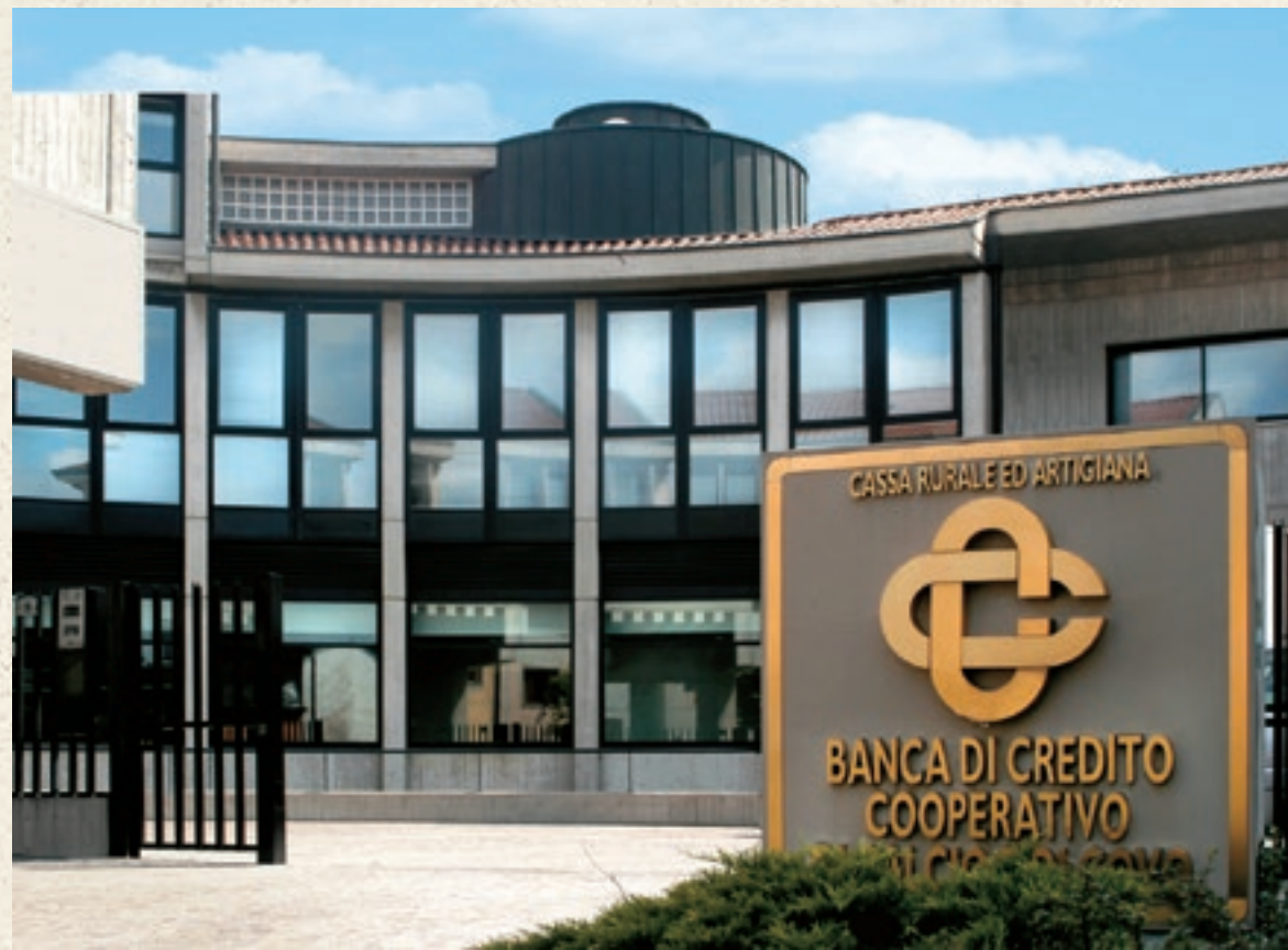
Veduta esterna della sede di Covo.
