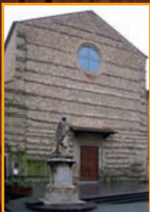
Basilica di San Francesco (facciata), Arezzo
