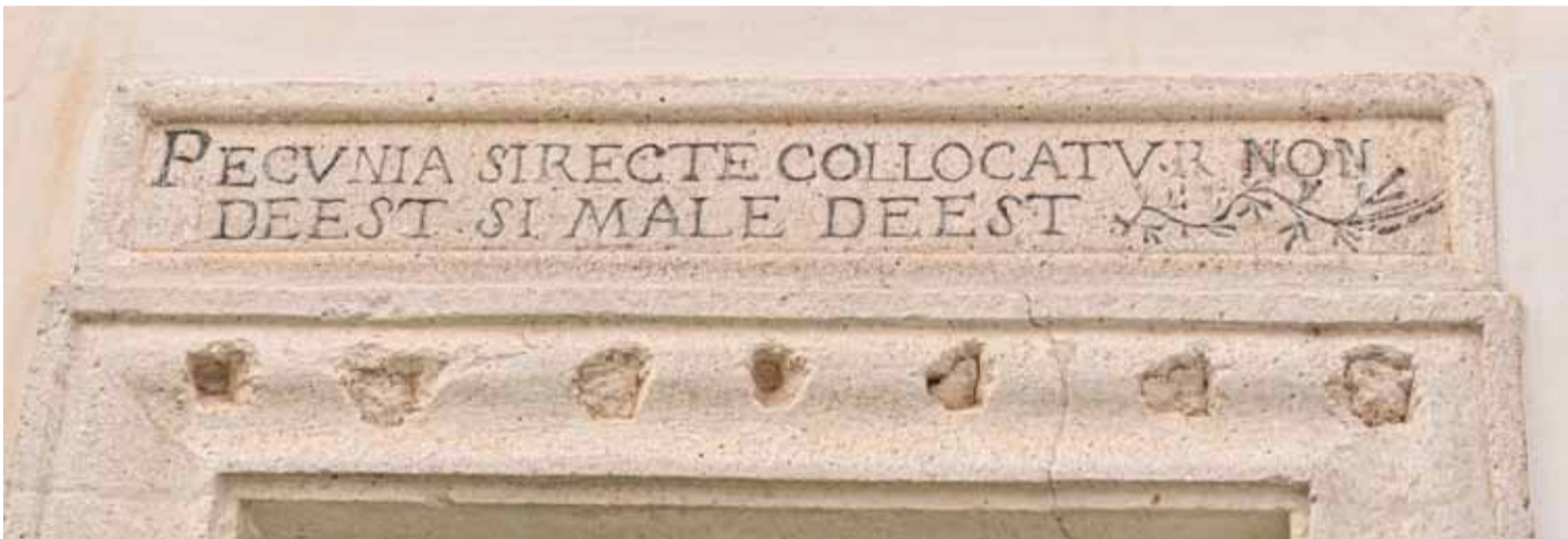
Hotel La Terra , già Palazzo Carducci, via Alfonso Giovene, architrave della porta, 1590
