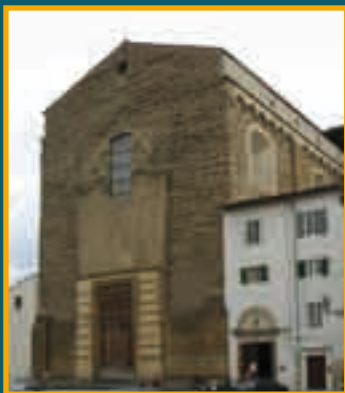
La facciata incompiuta della chiesa Santa Maria del Carmine, dove è sita la cappella Brancacci
