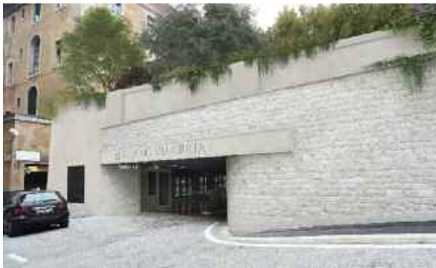
Parking di Via Giulia
